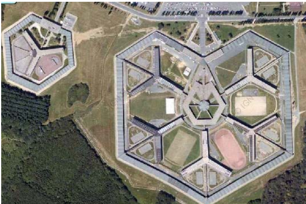
Photo 4 : Maison d'arrêt de Fleury-Mérogis
