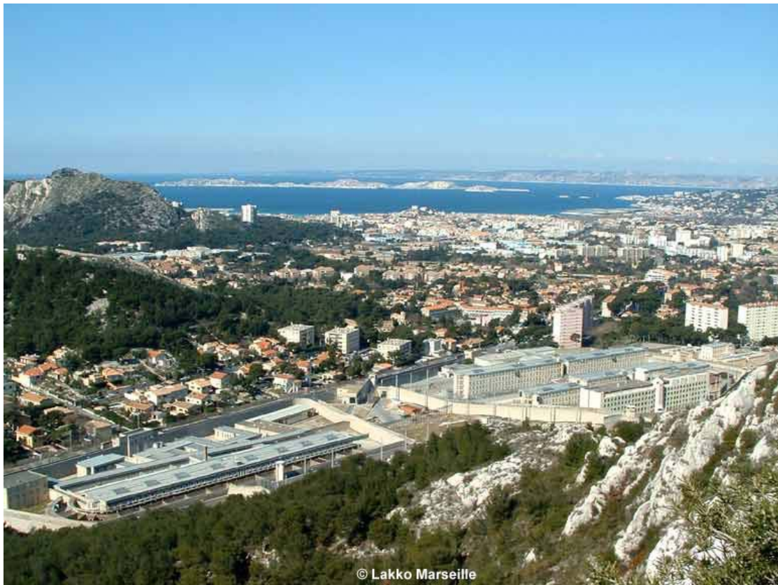
Photo 3 : Maison d'arrêt des Baumettes à Marseille
