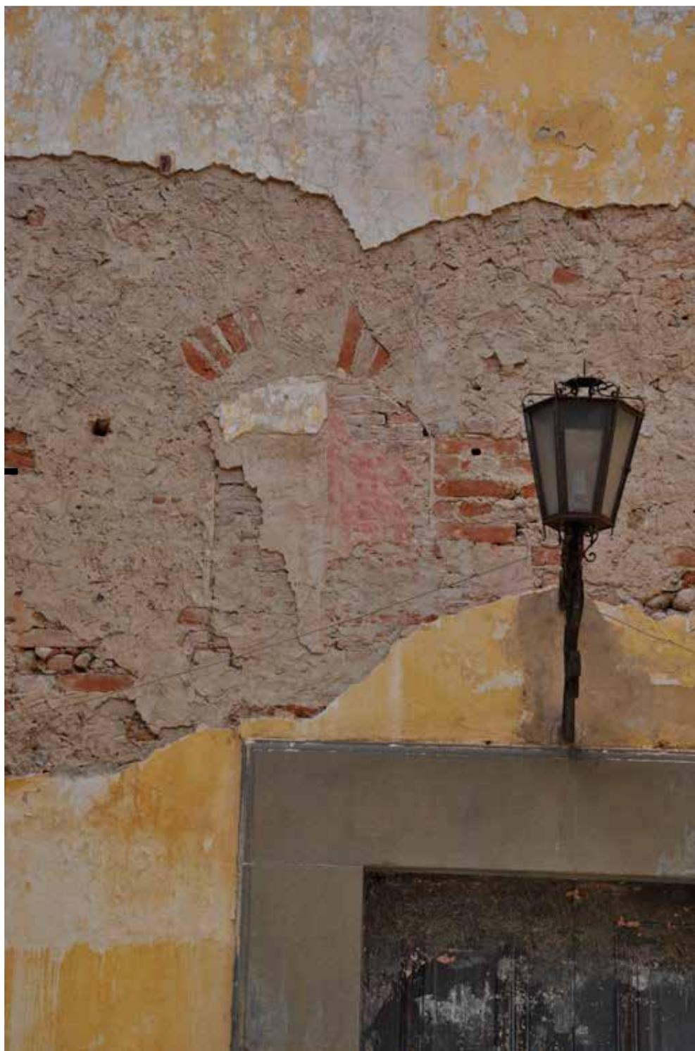
Figura 3 - Dettaglio di preesistenza sotto l'intonaco. Finestra murata di antica foggia
