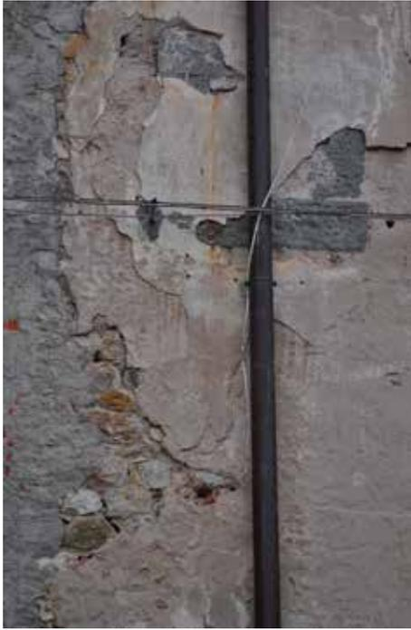
Figura 6 - Dettaglio di preesistenza sotto l'intonaco
