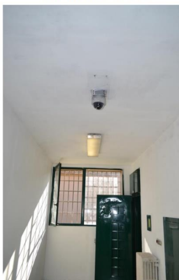
Telecamera n°69 isolamento lato A
