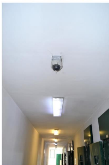
Telecamera n°70 isolamento lato A
