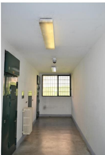
Telecamera n°72 isolamento lato B
