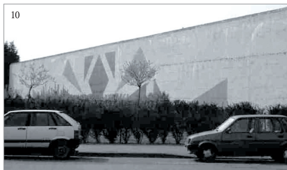
Mur d'enceinte de la maison d'arrêt de Valenciennes sur lequel des motifs géométriques ont été peints en 1990 pour faciliter son intégration dans le décor urbain. © Philippe Combessie
