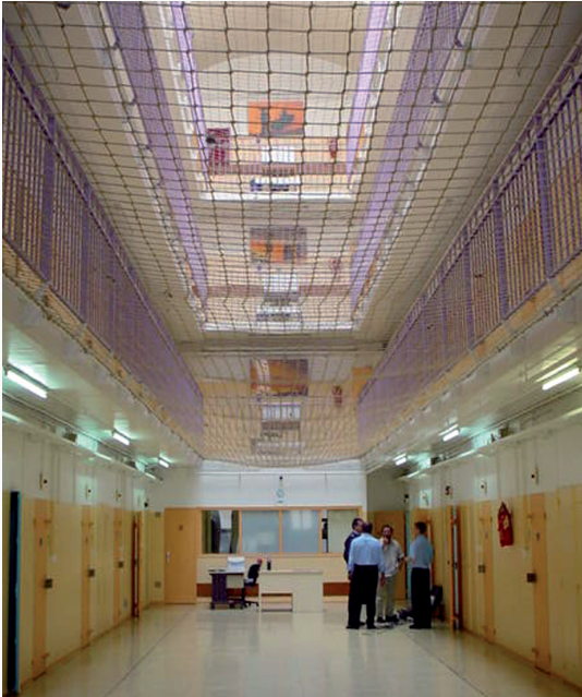
Fresnes, vue générale
